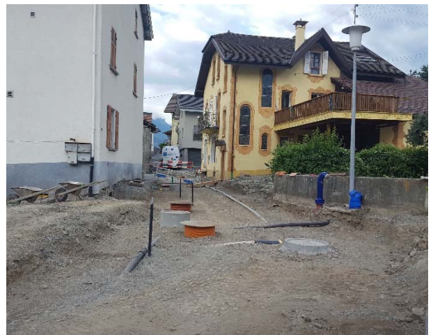
Figure 2: Photo du chantier
