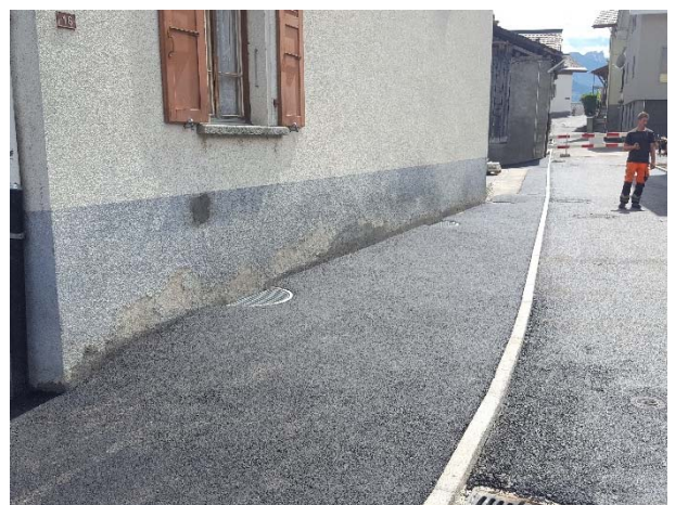
Figure 3: Situation après travaux
