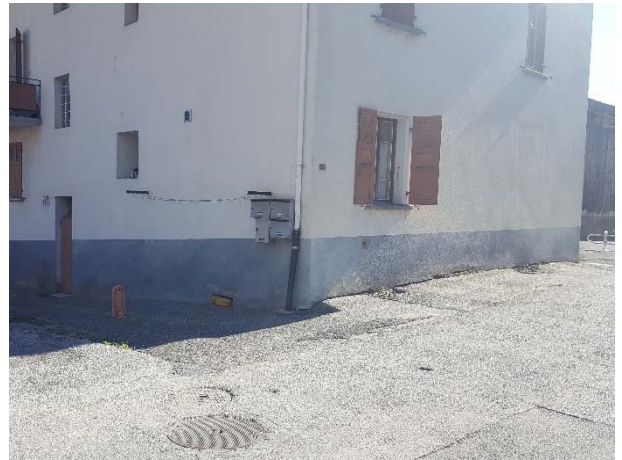
Figure 1: Situation avant travaux
